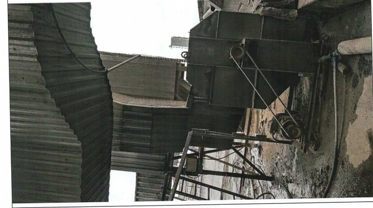
Nadmuchowcy piec grzewczy TERMAX typ MTP 4000
